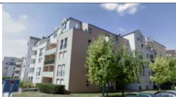
Immeubles collectifs - Grand ensemble Rue Marcel Pagnol
